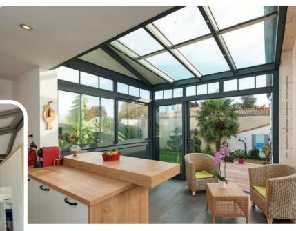
Véranda pourvue d'un éclairage par leds intégrés dans les chevrons. Le coulissant 3 vantaux, avec refoulement total sur 1 vantail, offre un accès direct et pratique à la terrasse. Couleur Gris antique gamme granité sablé Terra Cigala\* garantie 25 ans.
